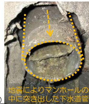
【下水道管とマンホールの接続部の耐震化】
